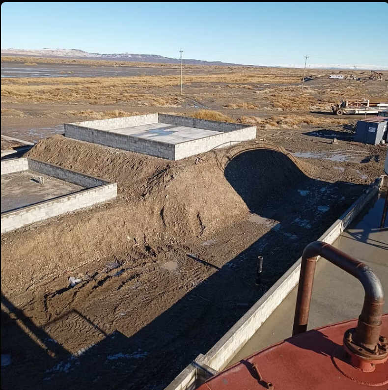
Obra Civil en Batería Puesto Vera
